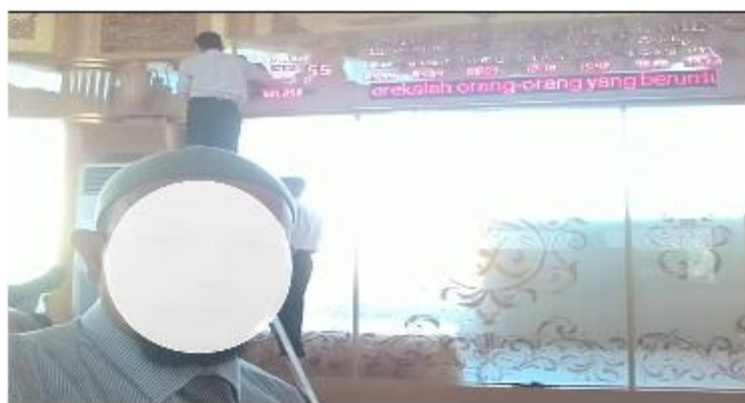
Gambar 5. Proses pemasangan peralatan di Masjid
