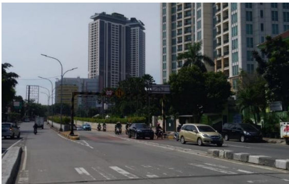
Gambar 6 Underpass Jalan Kramat Kebayoran Lama Jakarta Selatan
