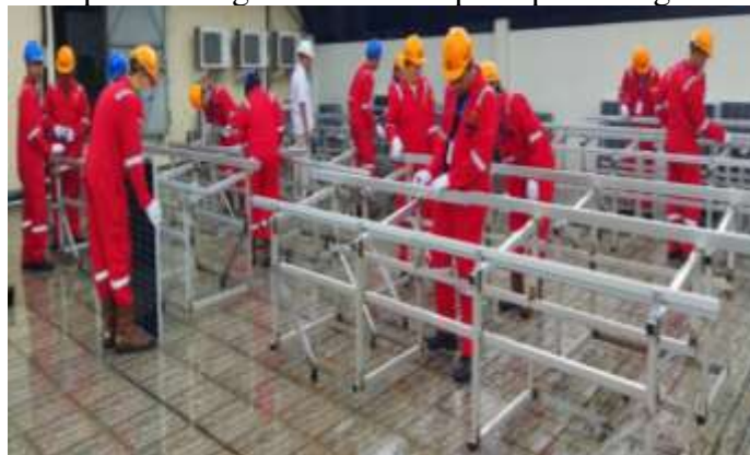
Gambar 3. Gambar Keterlibatan Peserta Pelatihan dalam Melakukan Praktek Pemasangan Konstruksi PLTS Sumber : Kementerian ESDM
