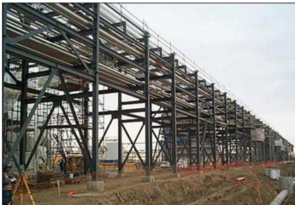
Gambar 1. Konstruksi Baja Pipe Rack dengan Pipa
