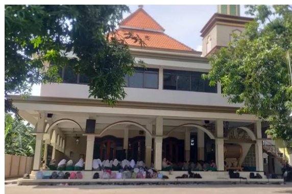
Gambar 4 : Tampak Depan Masjid dan Tata Cahaya Sumber : Dokumen Penelitian
