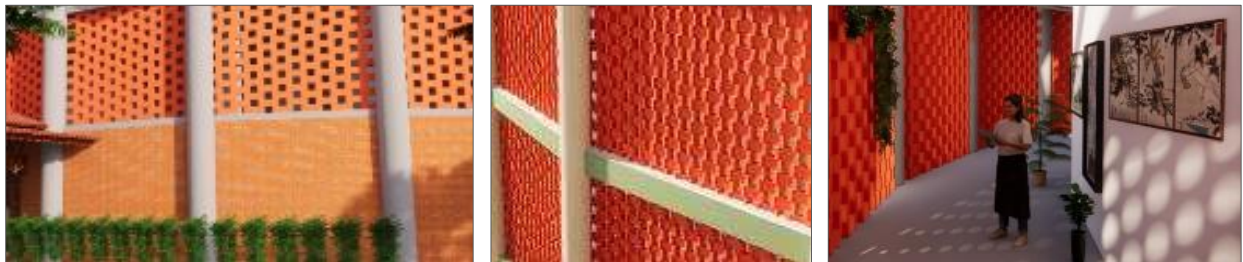
Gambar 8. Implementasi bata merah pada bangunan
