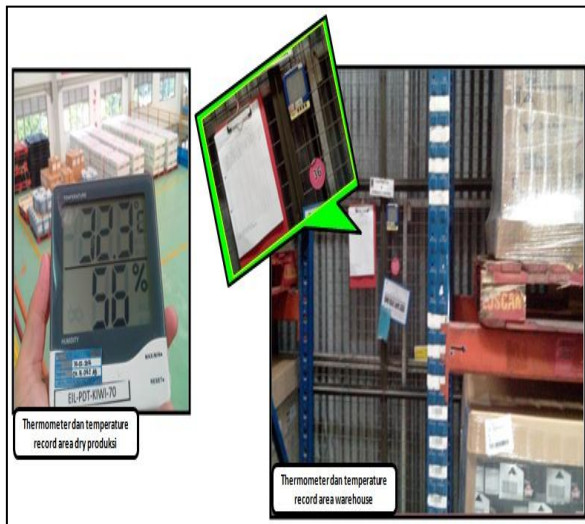
Gambar 9. Pemasangan thermometer pada area warehouse
