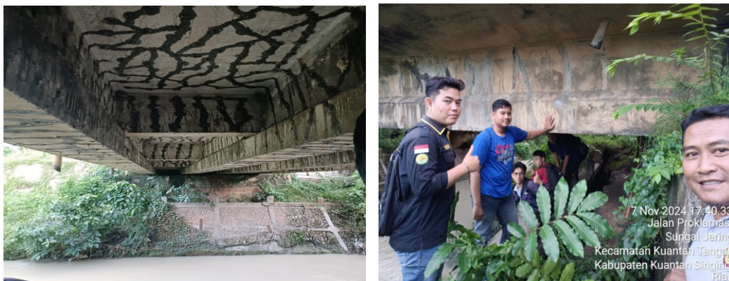
Gambar 2.1 Pemantauan Kesehatan Jembatan secara Visual
