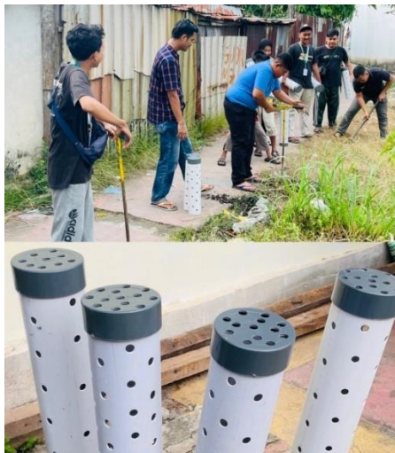
Gambar 2. Pembuatan lubang dan hasil pemasangan Biopori
