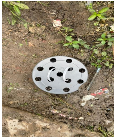
Gambar 4. Hasil pemasangan Biopori di tanah
