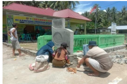
Gambar 4. Pembangunan tapal batas dusun
