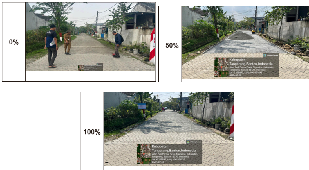
Gambar 1. Dokumentasi Pekerjaan Konstruksi Jalan Paving Perumahan Puri Permai 1 RT016 RW005 Kec. Tigaraksa
