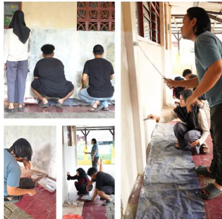
Gambar 4. Pengecatan Dasar
