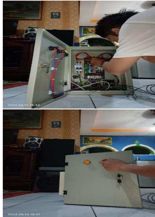
Gambar 10. Proses Perakitan Panel
