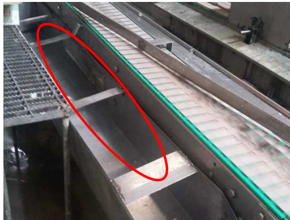
Gambar 4 Perbaikan Peralatan Kerja
