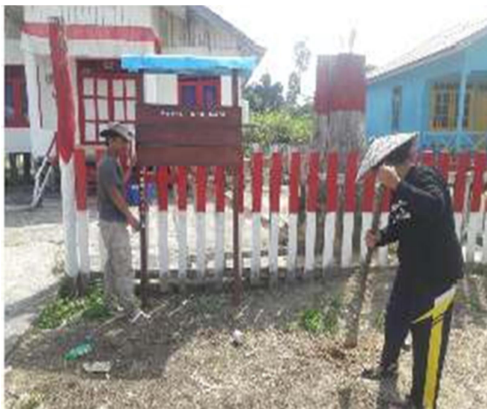
Gambar 5. Proses Pemasangan Papan Informasi Di Kantor Desa
