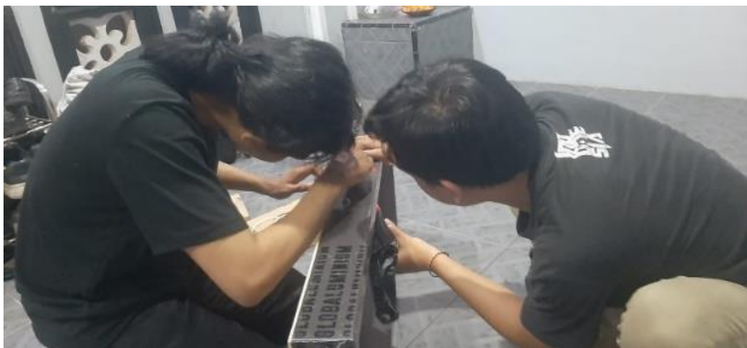
Gambar 4. Pengeboran untuk pemasangan kabel
