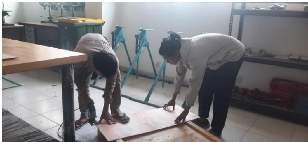
Gambar 3. Pemotongan Kayu triplek sebagai Pondasi Alat
