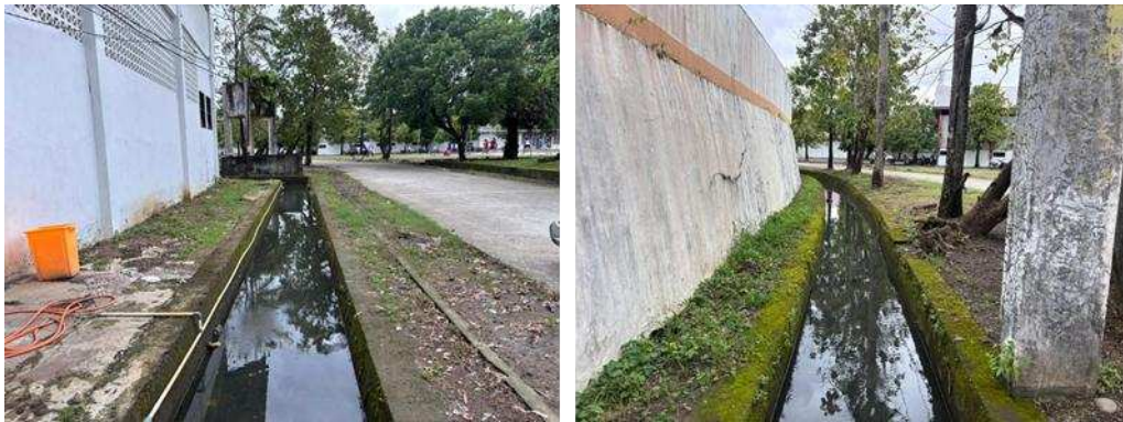
Gambar 4 Dokumentasi kondisi eksisting saluran
