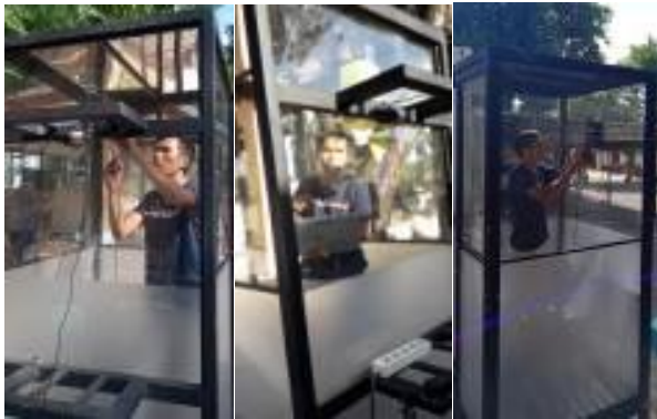
Gambar 8. Proses Pemasangan Kontrol Otomatis
