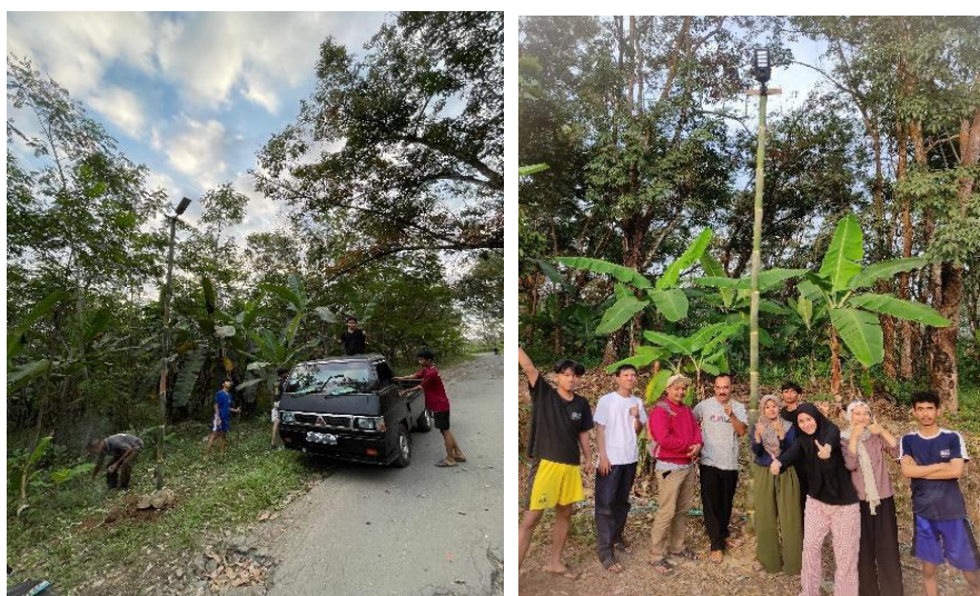
Gambar 3. Kegiatan Pemasangan PJU
