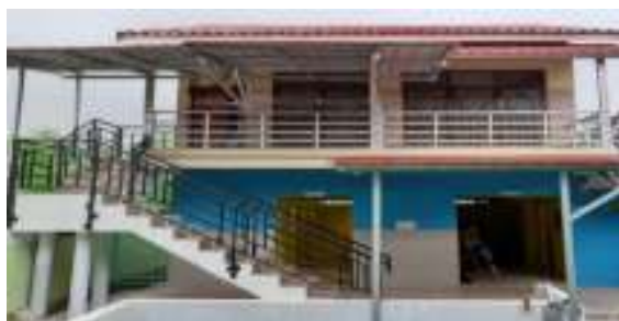
Gambar 2 Bangunan PKBM Linggih Sinau Banyusari (Sumber: Dokumentasi pribadi, 2022)
