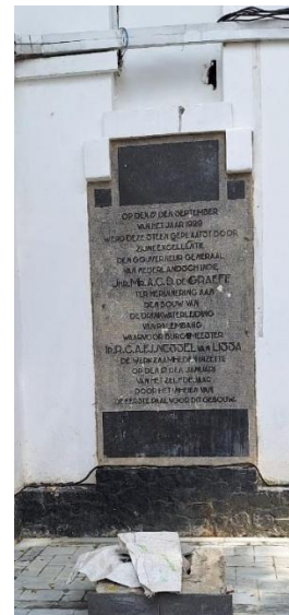
Gambar 16 Prasasti Sisi Kanan Kantor Ledeng Sumber : Dokumentasi Pribadi
