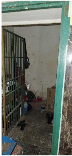
Gambar 13 Kondisi Ruang Brangkas Saat ini Sumber : Dokumentasi Pribadi
