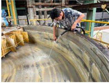
Gambar 5. Proses pembersihan dinding mesin krofta
