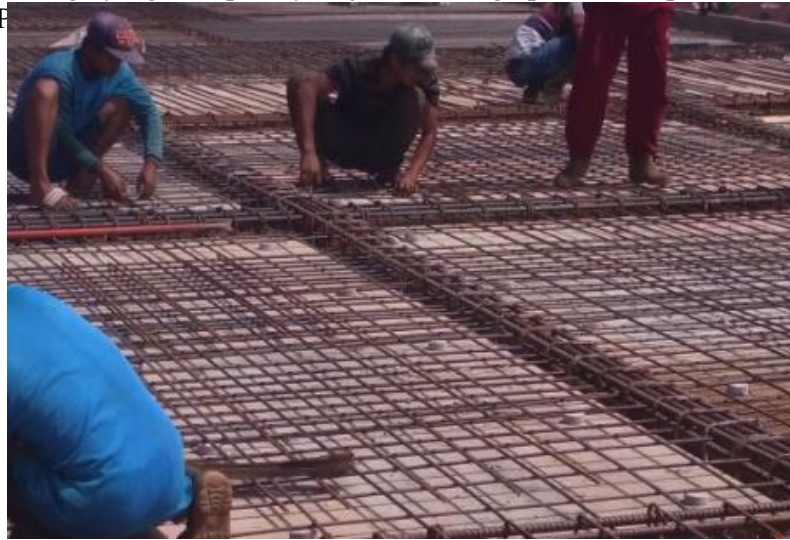
Gambar 5. Pekerjaan Balok dan Pelat
