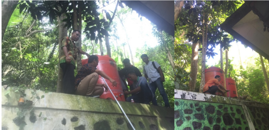
Gambar 4. Pemasangan Penampungan air (Sumber: Dokumentasi Lapangan, 2023)
