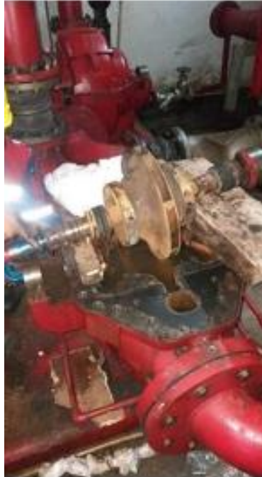
Gambar 6. Pembersihan Pompa Hydrant
