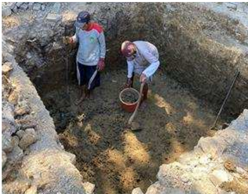
Gambar 6. Pekerjaan galian tanah pada bangunan bak IPAL
