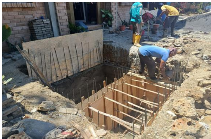
Gambar 8. Pekerjaan pengecoran beton pada bangunan bak IPAL
