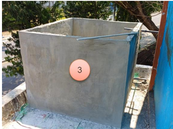
Gambar 10. Pekerjaan bak koagulasi (3) pada bangunan bak IPAL
