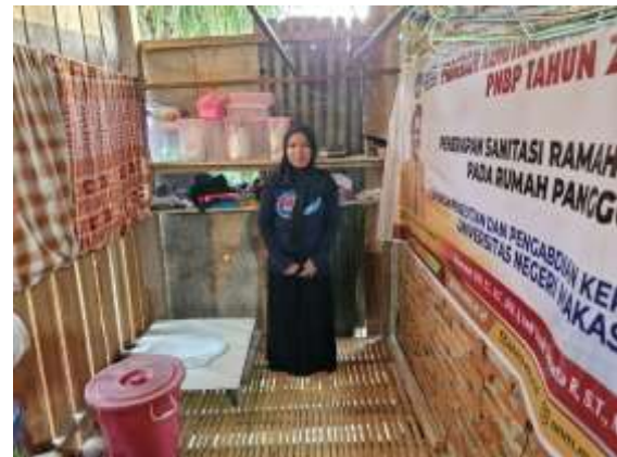
Gambar 2. Dokumentasi Pembuatan Jamban Keluarga pada Rumah Panggung
