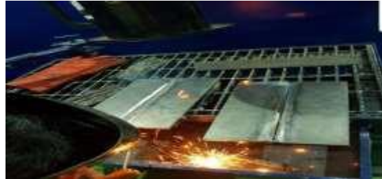
Gambar. 2 Pengelasan Pelat
