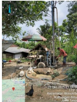
Gambar 4. Proses Pengeboran Sumur Bor
