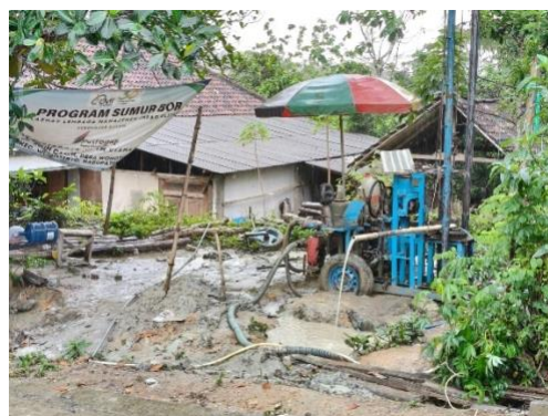
Gambar 5. Proses Pemasangan Pipa
