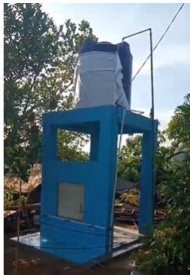
Gambar 6. Sumur Bor di Dusun Caren
