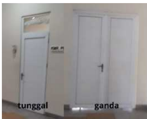
Gambar 10. Pintu ruangan Sumber: dokumentasi pribadi, 2024
