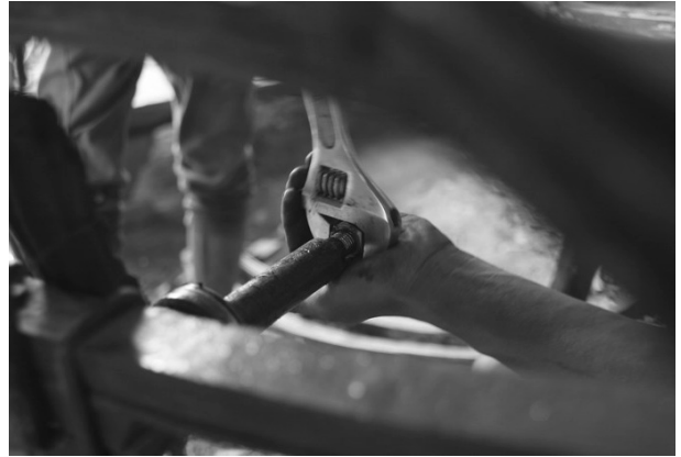
Frame 3. Pemasangan baut.
