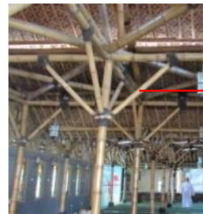
Gambar 24. Sambungan tiang dengan palang dan penopang
