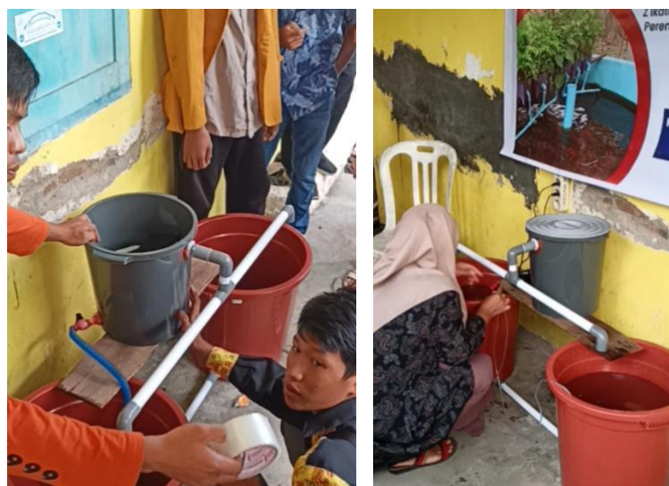
Gambar 3. Pembuatan Instalasi Budikdamber
