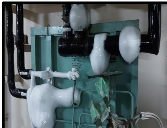
Figure 3. Kondisi expansion valve tertimbun es Sumber: Dokumen pribadi (2023)
