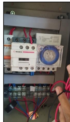
Gambar 13 wiring NC timer theben ke coil kontaktor
