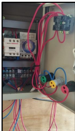
Gambar 11. Pemasangan selector switch ke
