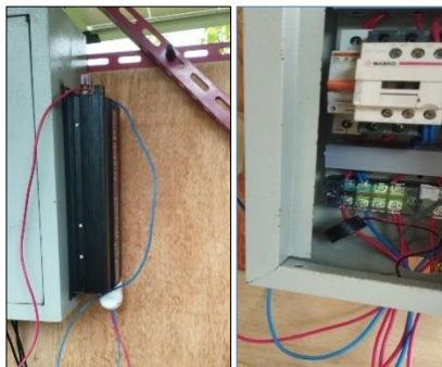
Gambar 5. pemasangan inverter ke MCB
