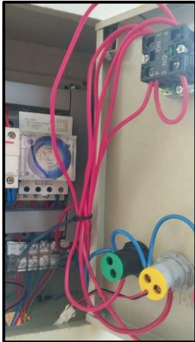
Gambar 9. Pemasangan Selector switch ke timer theben
