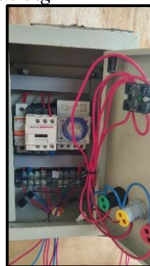
Gambar 7 Pemasangan MCB ke selector switch
