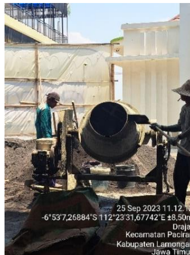
Gambar 6. Pembuatan Beton
