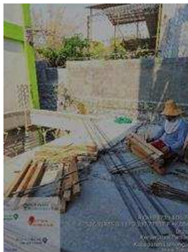
Gambar 4. Pembuatan Stang Pengaku
