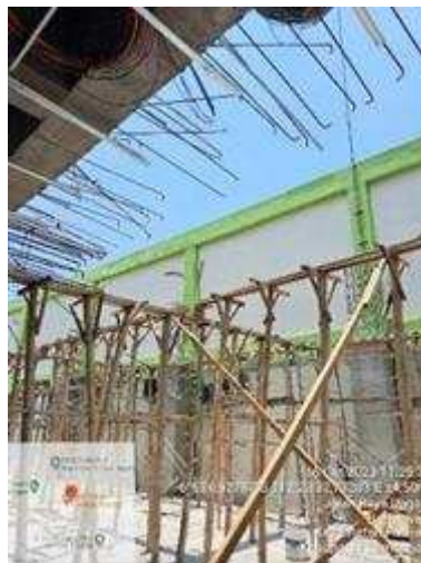
Gambar 7. Pembongkaran Bekisting
