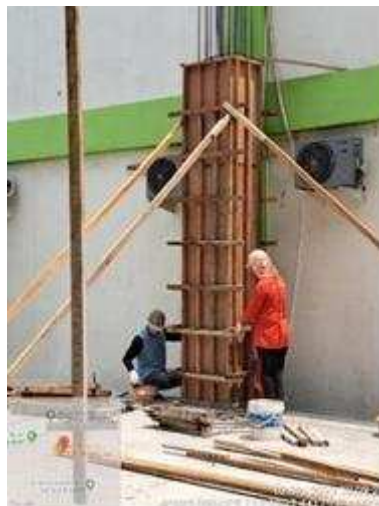
Gambar 5. Pemasangan Bekisting
