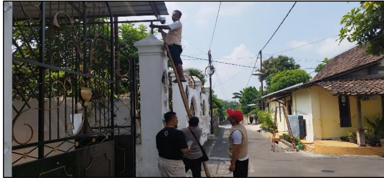
Gambar 7. Proses pemasangan 12 unit CCTV aktif yang ditempatkan di titik-titik strategis
