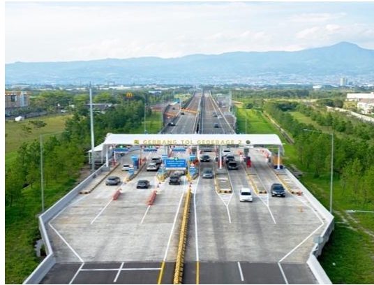
Gambar 4. Summarecon Bandung, “Exit Tol Bandung” (On-line), tersedia di: https://www.summareconbandung.com (29 Mei 2025).
