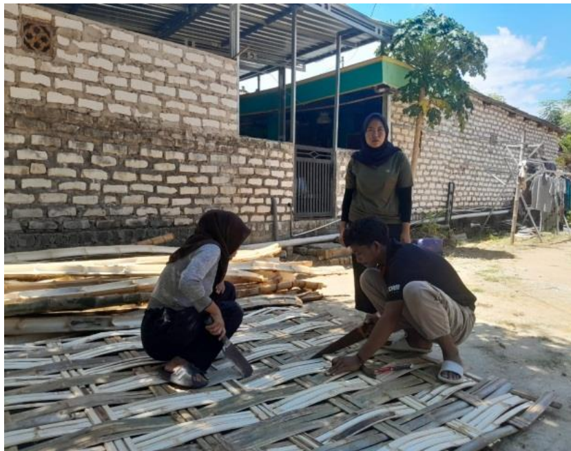
Gambar 3. Pemotongan bambu dan gedek
