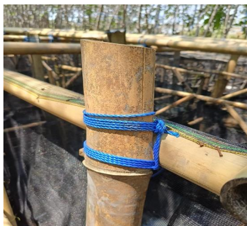
Gambar 5. rangka bambu dengan sistem ikatan rangkap (ganda) menggunakan tali nilon
