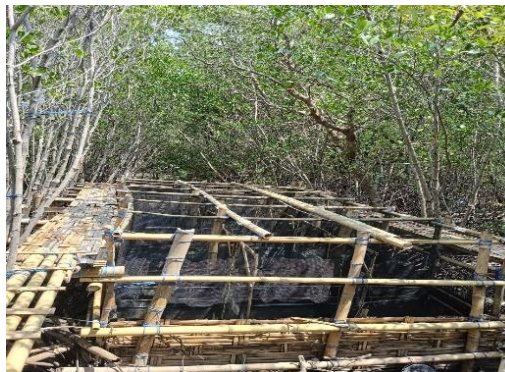
Gambar 7. Foto dinding kolam menggunakan gedek ayaman bambu
