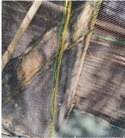
Gambar 6. Foto dinding dalam dengan lapisan waring
