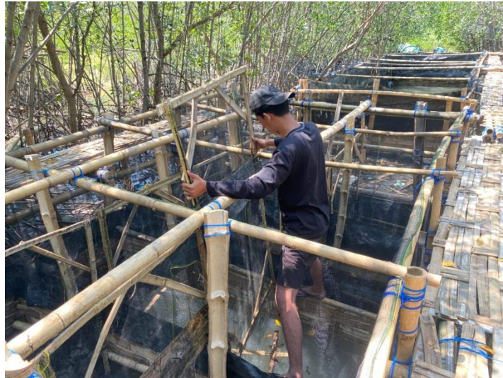
Gambar 4. pemasangan struktur kolam, serta pembuatan jembatan untuk akses monitoring dan perawatan.
