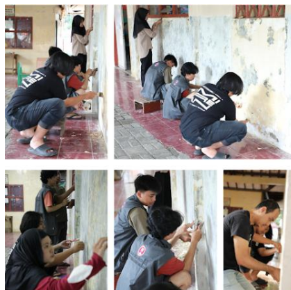
Gambar 3. Pengamplasan dan Plamir
