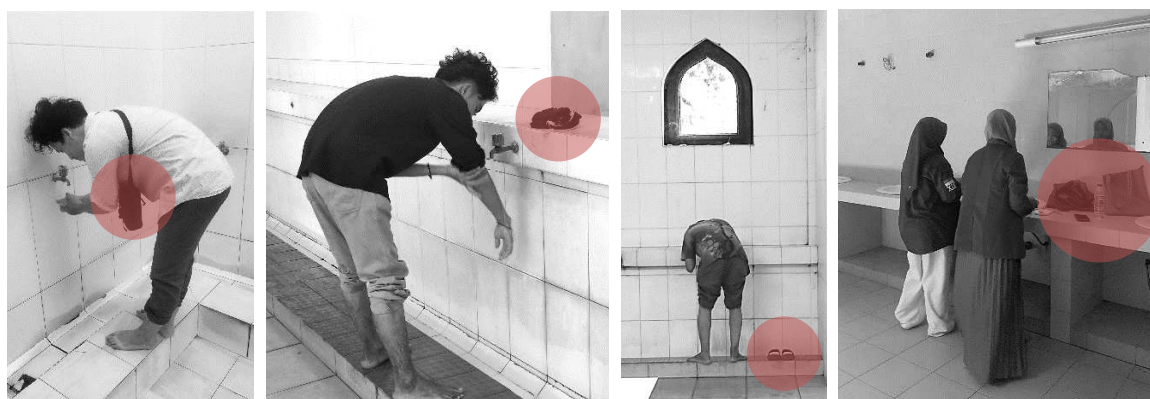
Gambar 8. Perilaku Pengguna Akibat Kurangnya Fasilitas Sumber gambar: Dokumentasi, 2024
