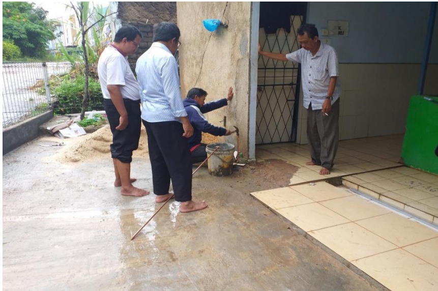
Gambar 3. Pemasangan Grounding Mushola Al-Muttaqin
