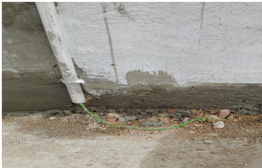
Gambar 4. Pemasangan Instalasi groundingi Mushola Al-Muttaqin
