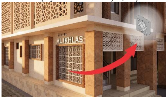
Gambar 3. Gambar pengaplikasian roster pada bangunan Sumber : analisa pribadi
