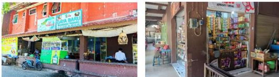
Gambar 8. Kios Blok E Sumber: Dokumentasi Pribadi
