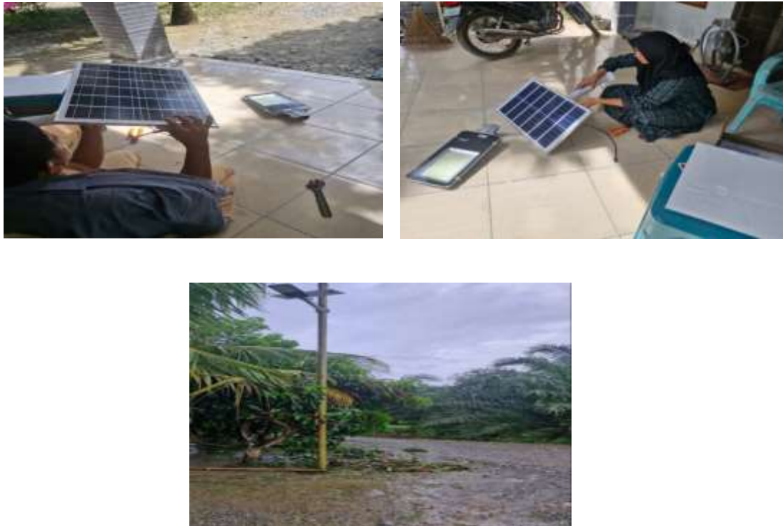
Gambar 2. Gambar Pemasangan Solar Panel
