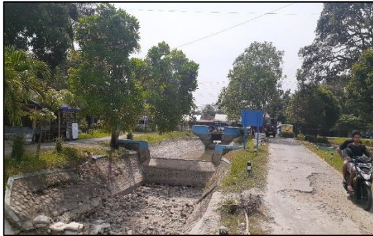
Fig. 2. Existing Condition Hm 00+00
