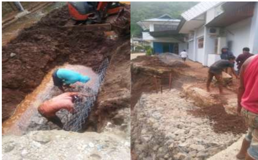
Gambar 4. Pemasangan Kawat Bronjong Di Sepanjang Galian
