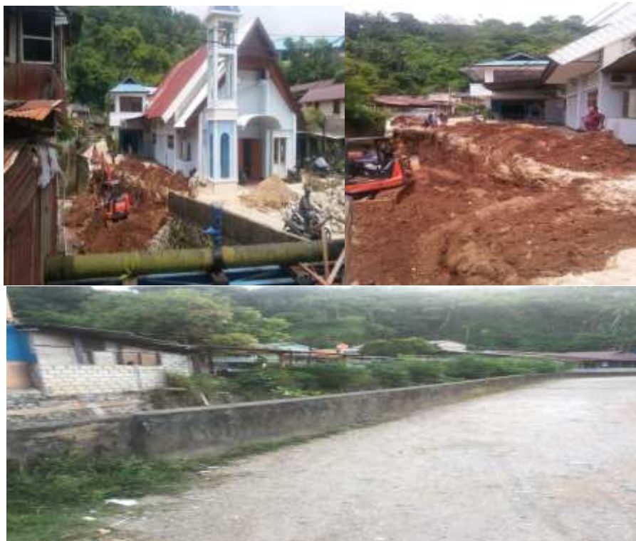
Gambar 6. Pemasangan Dinding Penahan Tanah
