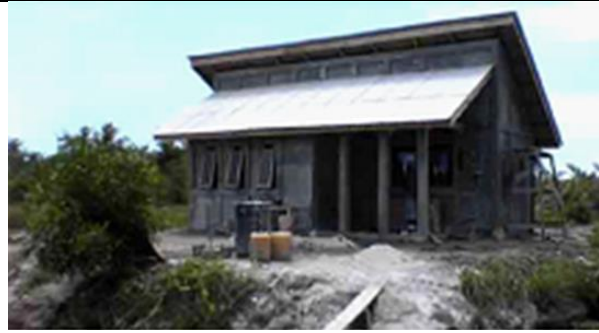
Gambar 6. Bangunan sudah selesai dikerjakan
