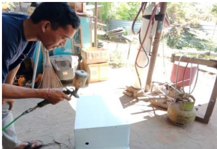
Gambar 6 Pengecetan casing box panel sistem kontrol.
