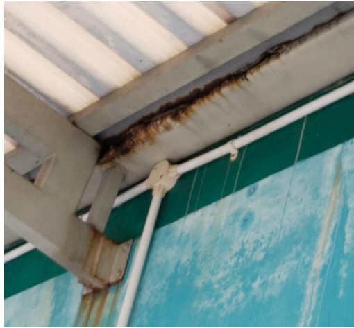
Gambar 10. Instalasi listrik di bawah talang atap
