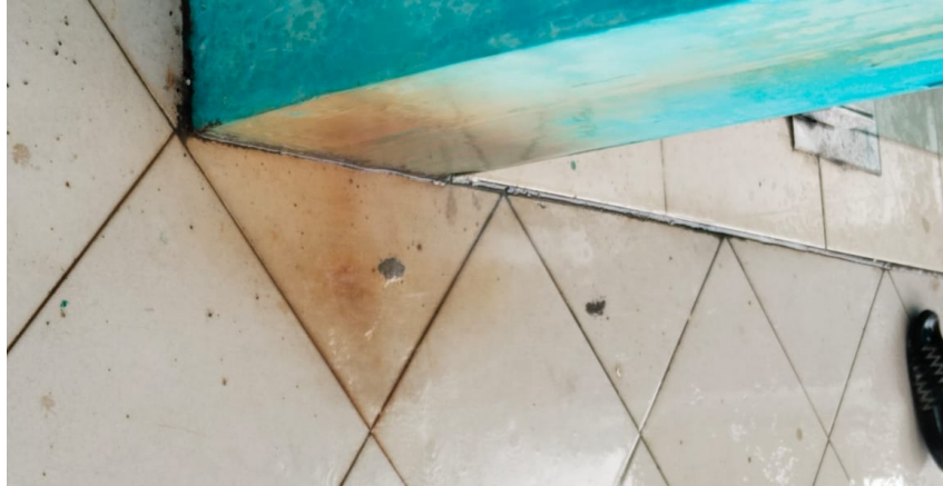
Gambar 3. Rembesan yang mengotori lantai
